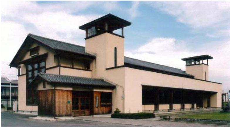
写1 真岡市久保講堂（昭和13年建築、栃木県の登録第1号） 撮影：小野吉彦
