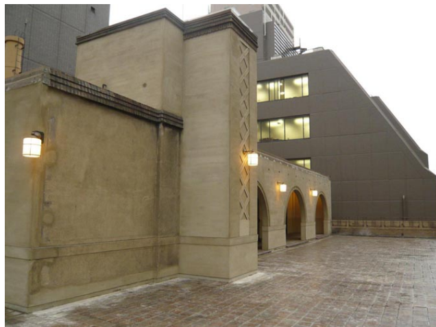
改修工事完了後の屋上テラスの様子
