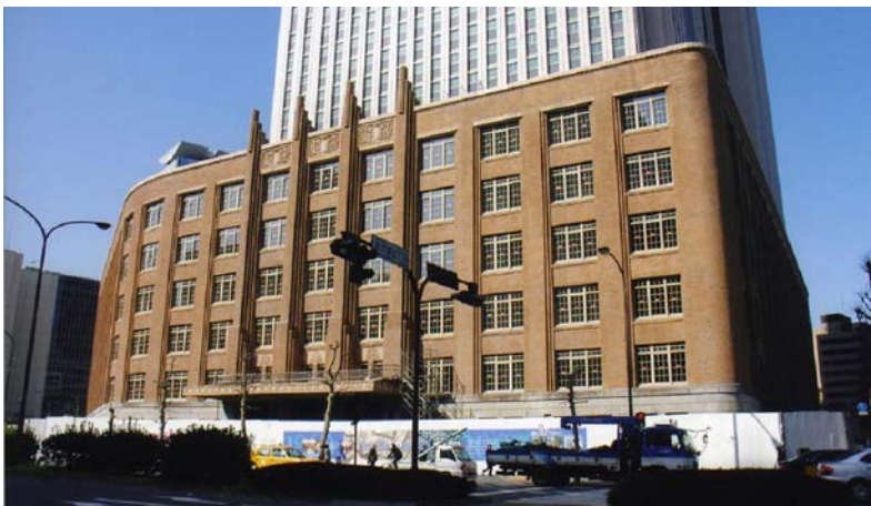
写2 旧文部省庁舎（昭和7年建築、後方は新合同庁舎）
